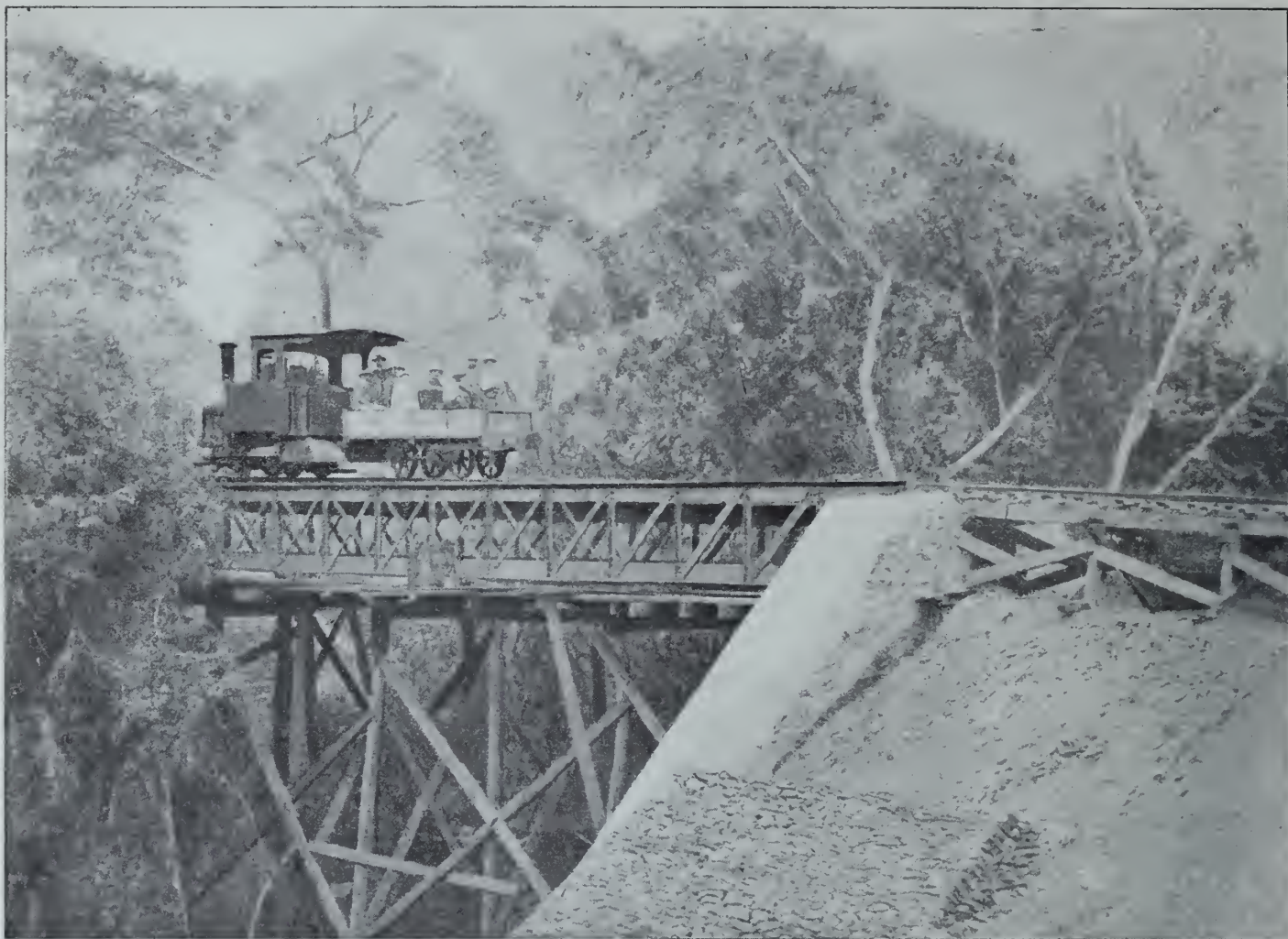
Le pont du ravin de la Mission, au kilomètre 9.3. (D'après une photographie du capitaine A. Weyns.
