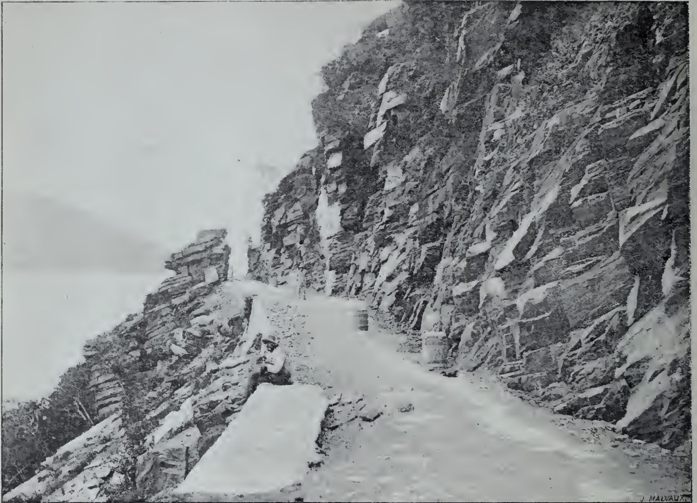
La plate-forme de la voie au kil. 2.700. (D'après une photographie de M. Demeuse, prise en 1890.)
