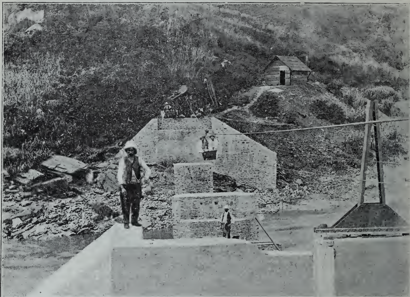
Construction du pont de fer de la Mpozo. (D'après une photographie de M. le capitaine A. Weyns.)
