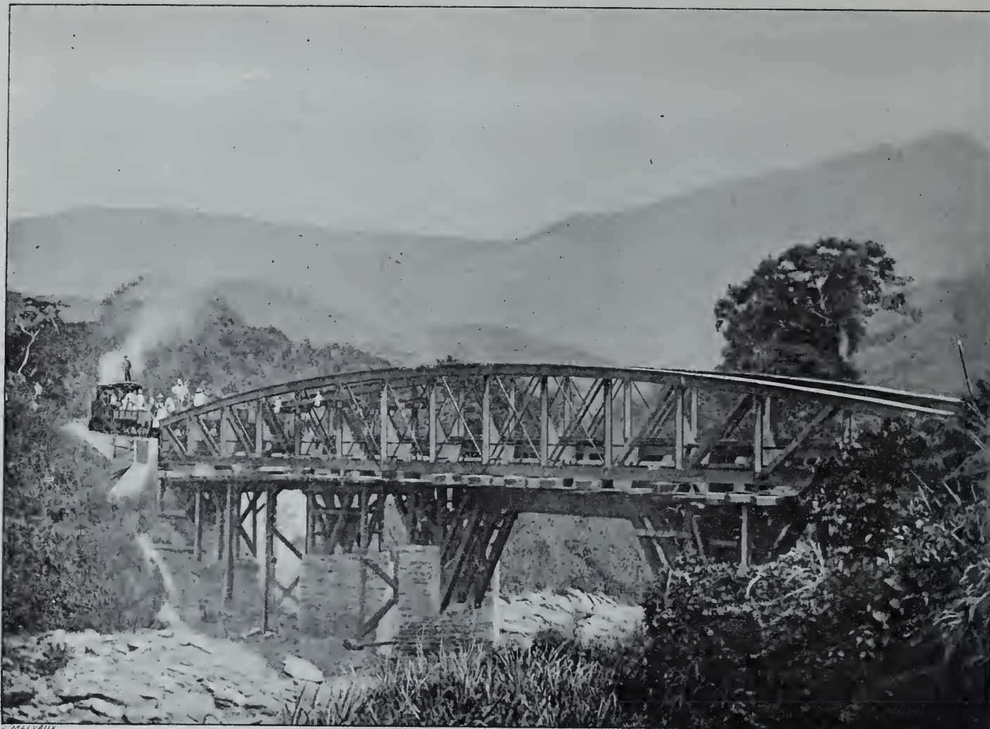
Le pont de fer de la Mpozo. (D'après une photographie de M. le capitaine A. Weyns.
