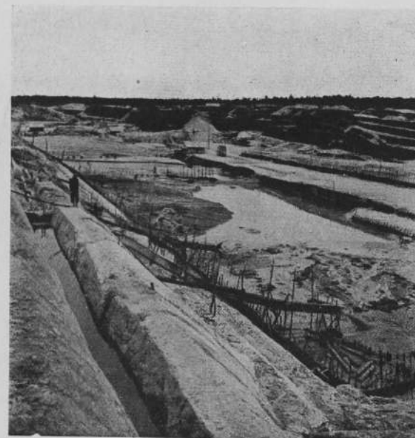
PERAK (env. d'IPOH). Mine hydraulique. — Monitors.
