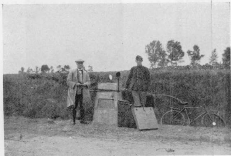
Terme Nord de la base de Habay, avec hélio pour l'observation de direction.
