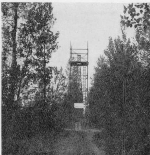
Terme Sud de la base du Canal maritime avec signal.
