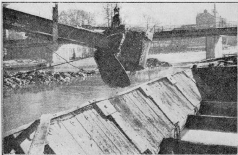
FIG. 31. — Chaland à clapets pour débris rocheux.
