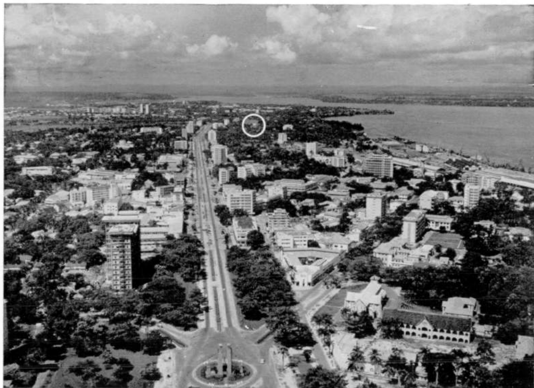
FIG. 6. — Vue générale de Léopoldville avec l'Avenue Albert et l'emplacement du centre-pilote d'orientation professionnelle, aux abords du fleuve Congo.
