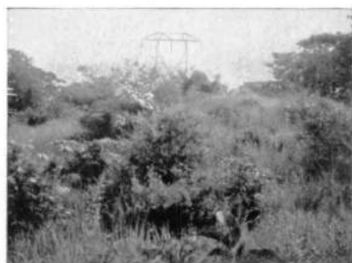
FIG. 1. — Végétation dont se couvre une plate-forme de ligne H. T. après une seule saison de pluies.
