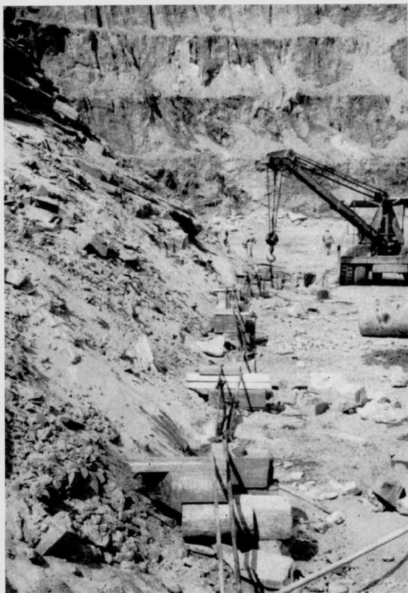
PHOTO 3. — Le 19 octobre: câbles reliés longitudinalement.
