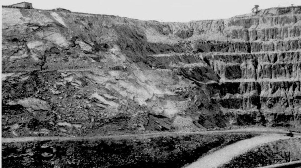
PHOTO 1. — Vue d'ensemble de la paroi de carrière en mouvement.
