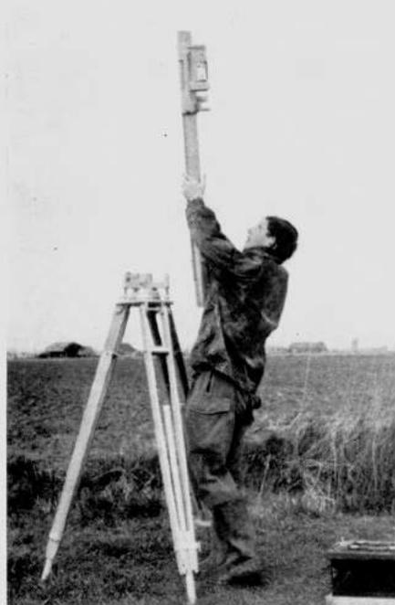
Fig. 1. — Placement de la colonne centrale sur le trépied.
