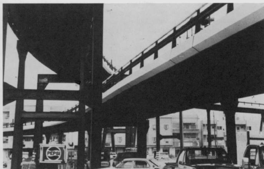
Fig. 4 — Viaducs superposés à Riyadh, en Arabie Séoudite.
