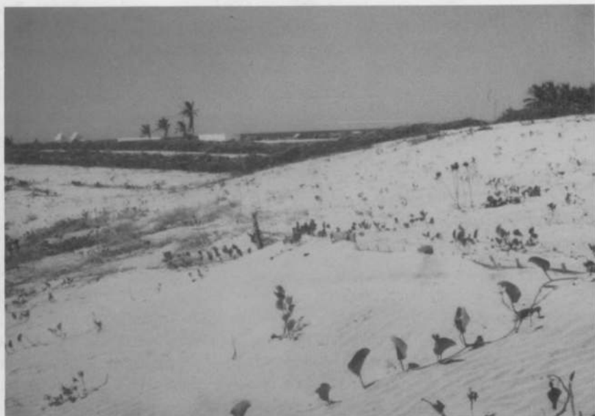
Fig. 5. — Duinfixatie met matten, rijshouthagen en Ipomea pes-caprae , Omgeving van Loumpoul, Senegal (Foto M. Reynders).
