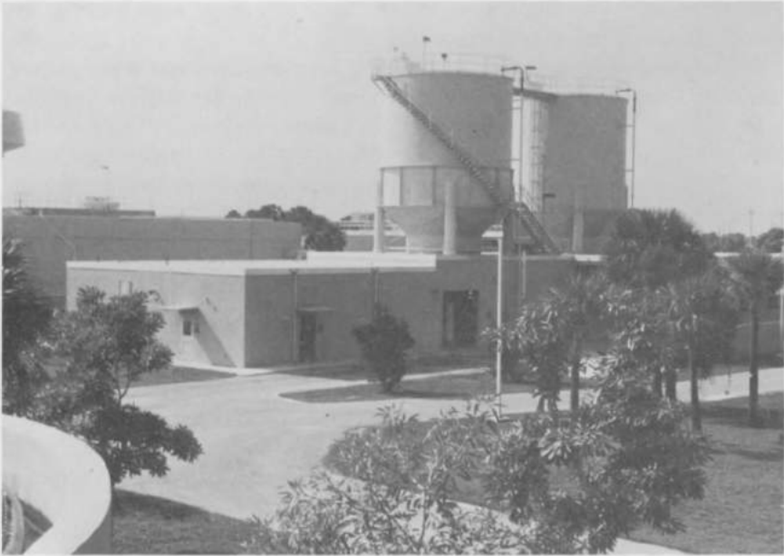
Fig. 2. — Kalkopslag en dosering te Boca Raton (Florida).
