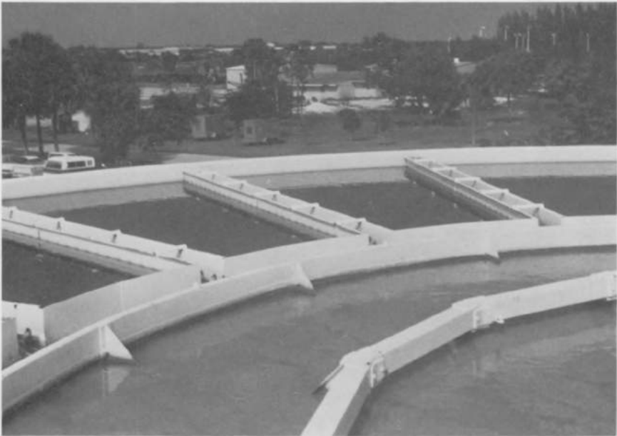
Fig. 3. — Dosering van kalk in de dekantor te Boca Raton (Florida).
