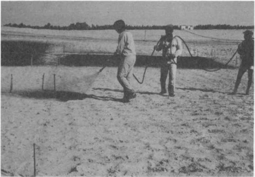
Fig. 12. — Het toedienen van bodemconditioneringsmiddelen als mulch gebeurt door eenvoudige verspuiting van verdunde waterige oplossingen of emulsies.
