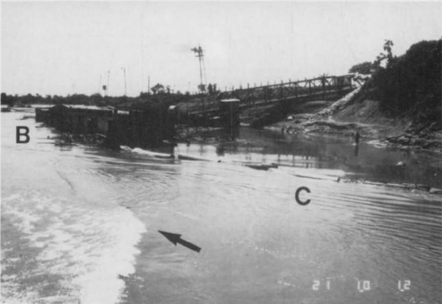
Fig. 11. — Photos du port de Yurimaguas : sur la photo prise d'avion se remarque la confluence des rivières Ucayali (gauche à droite) et Paranapura (haut en bas) et l'ensablement provoqué par le ponton et ses ancrages (A); sur la photo prise du fleuve se voit le ponton posé sur le banc de sable et sur les troncs d'arbres et branchages (B), ainsi que le câble d'ancrage muni de troncs d'arbres (C).
