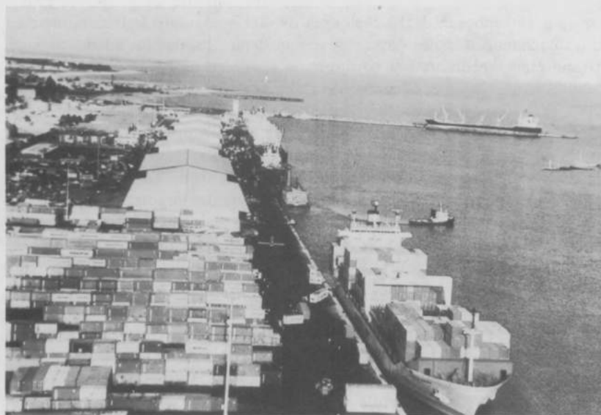
Fig. 2. — Vue d'ensemble du port de Cotonou. À l'avant-plan, le poste à conteneurs.
