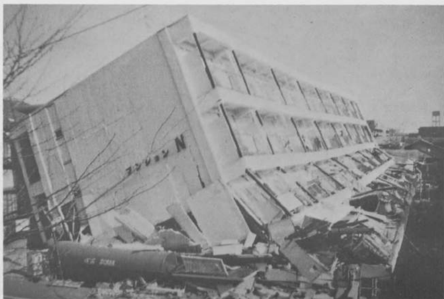
Fig. 22. — Volledige vervloeiing van een funderingsmassief (Kobe, 1995).
