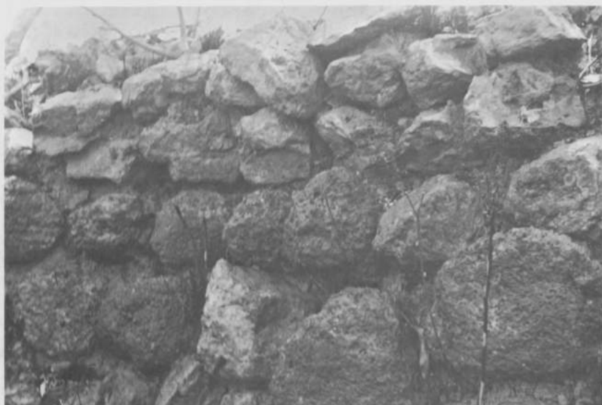
Fig. 4. — Détail d'un mur où se conjuguent blocs de latérite et blocs de quartz (site 49, structure 71).
