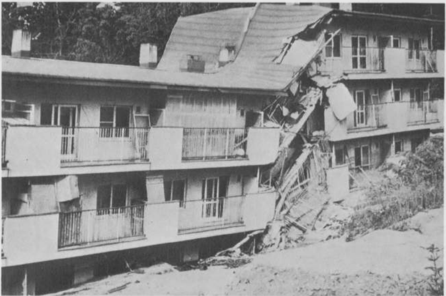
Fig. 17. — Differentiële zettingen t.g.v. gedeeltelijke vervloeiing van het funderingsmassief (San Francisco, 1989).
