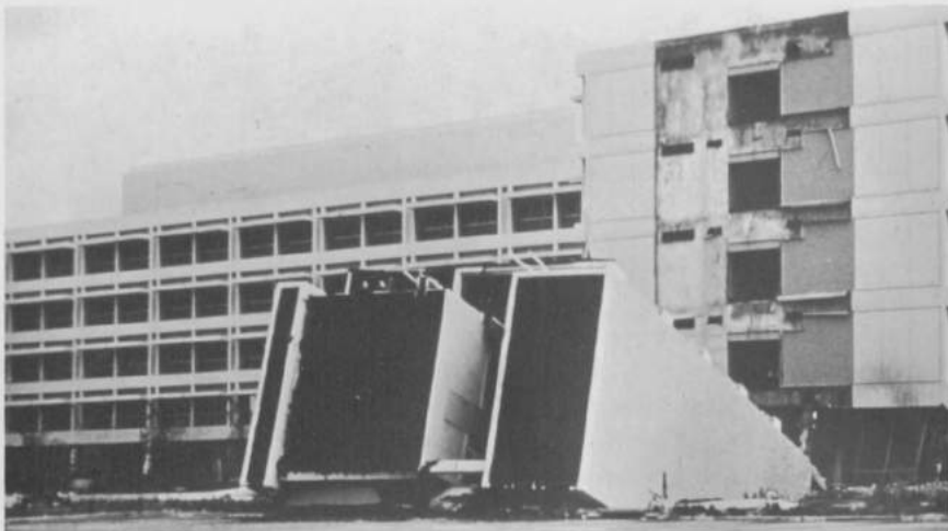
Fig. 2. — Typische schade door vervloeiing onder bestaande funderingen.
