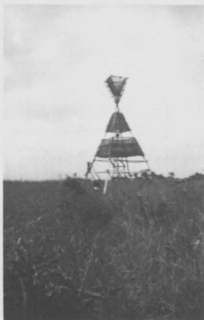
Fig. 6 et 7. — Signaux de 11 et 16 m au Kasai (1951-1952) avec supports indépendants pour l'instrument. Photos : L. Schoenaers.
