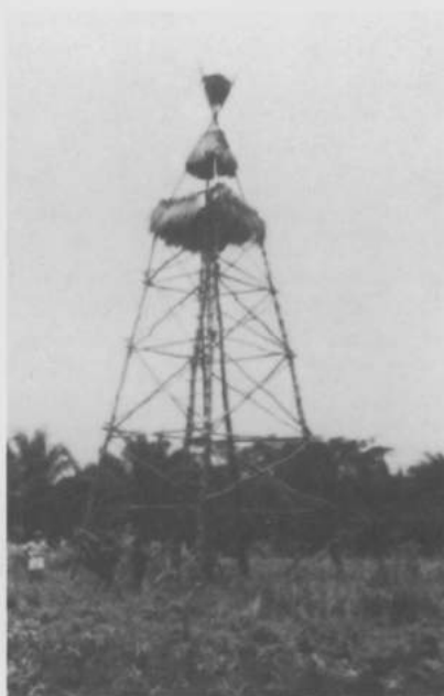
Fig. 6 et 7. — Signaux de 11 et 16 m au Kasai (1951-1952) avec supports indépendants pour l'instrument. Photos : L. Schoenaers.
