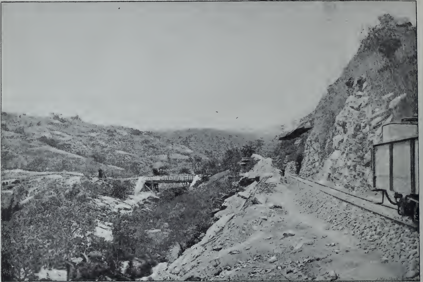
Le ravin Léopold. — La voie le long du flanc gauche et le pont de fer. (D'après une photographie de M. Hector Cambier.)
