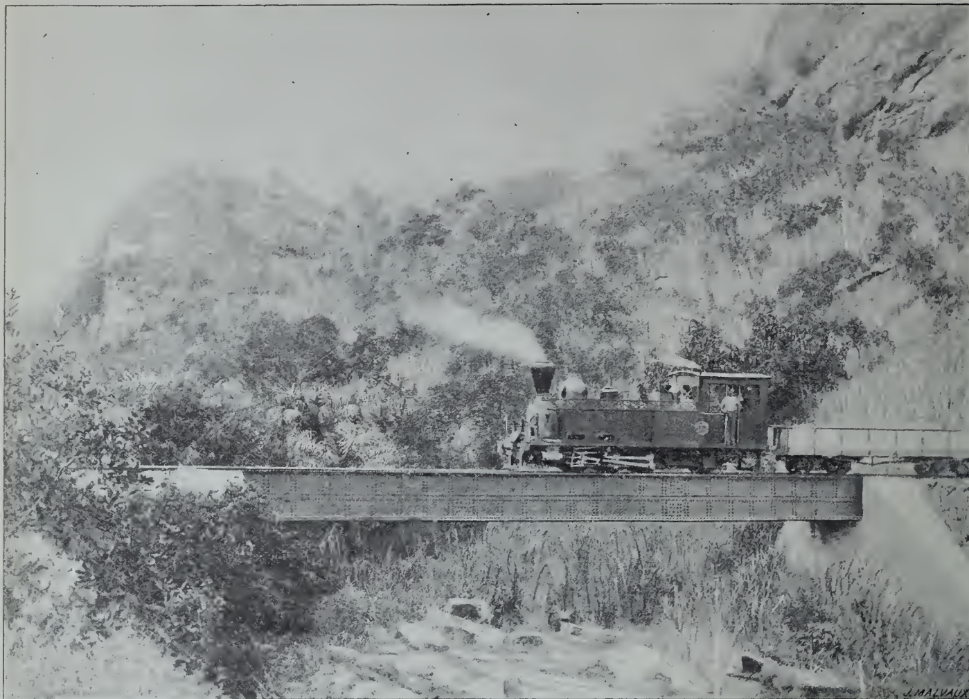
Le pont du ravin Léopold. (D'après une photographie du capitaine A. Weyns.)
