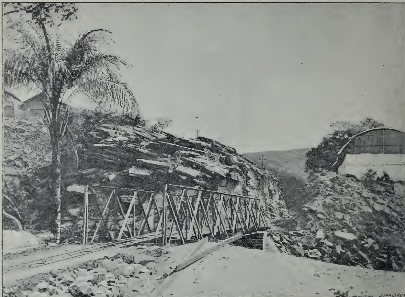
Le chemin de fer du Congo. — Le premier pont de la ligne, à la sortie de la gare de Matadi.
