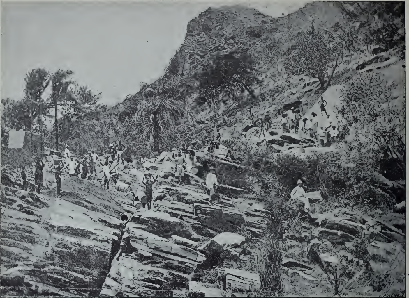
Le ravin Léopold. — Construction des maçonneries du pont. (D'après une photographie prise en 1890 par M. Demeuse.)
