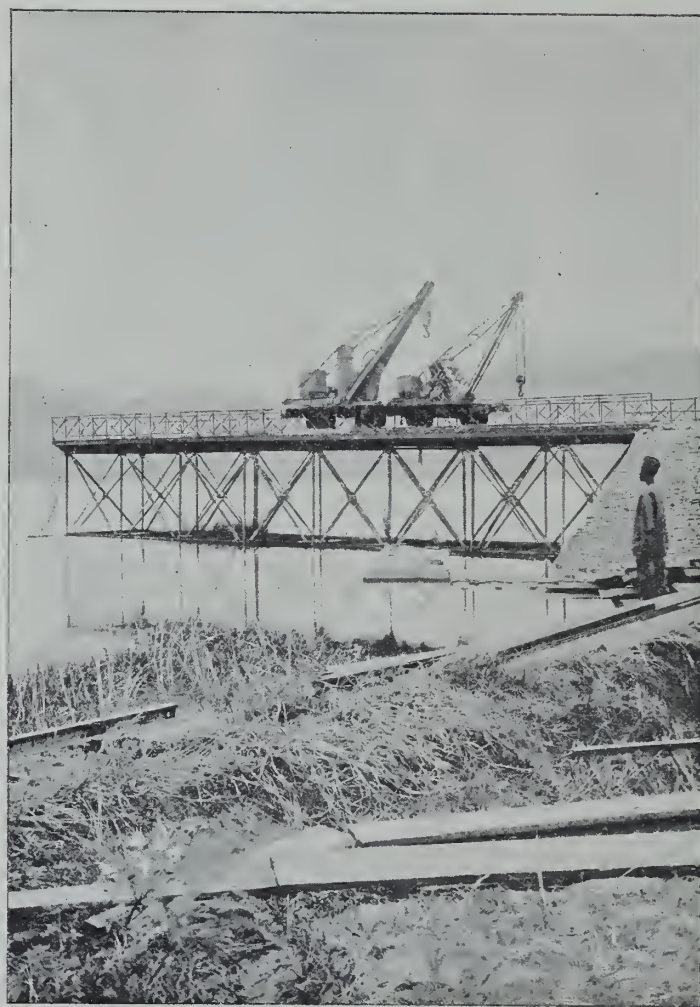
Le pier de Matadi. (D'après une photographie de M. Wyns.)
