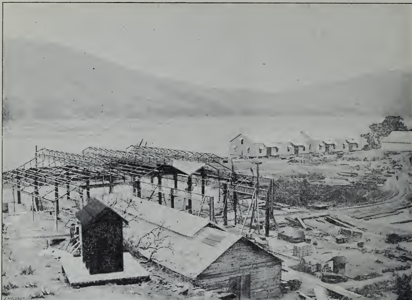
Matadi. — Un coin de la gare en construction en 1891. (D'après une photographie de M. le lieutenant Weyns.)
