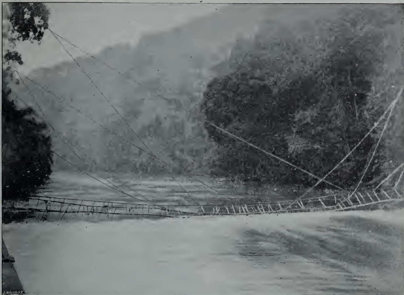
Un pont de lianes. (D'après une photographie de M. F. Demeuse.)
