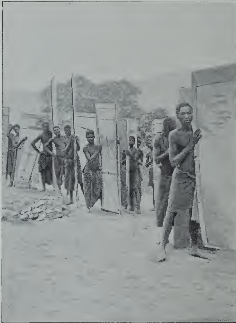
Transport des plaques de la coque du steamer Baron Lambert .
