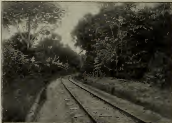
LA VOIE FERRÉE AU KILOMÈTRE 8 (GRANDS LACS).
