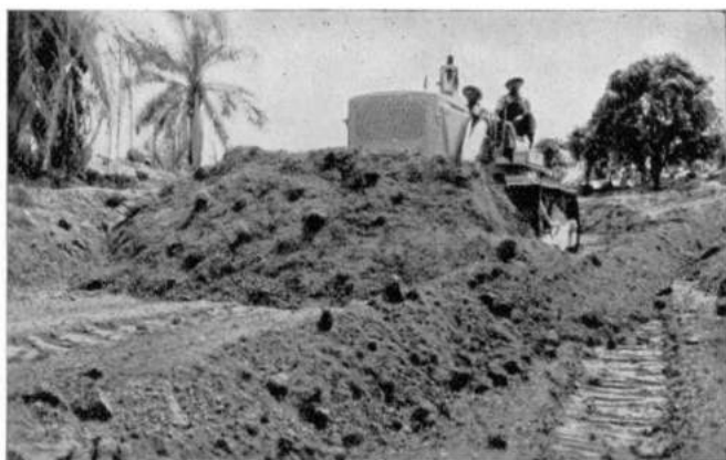
Jonction C. F. L.-K. D. L. / Section Kabalo-Kabongo. Terrassements au bulldozer.
