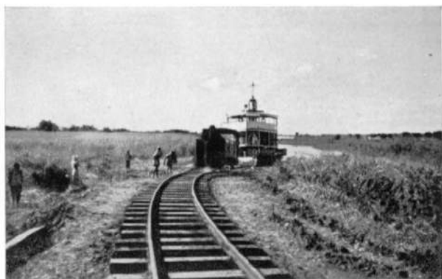
Jonction C. F. L.-K. D. L. / Section Kabalo-Kabongo. Débarquement de la première locomotive à Zofu rive gauche.
