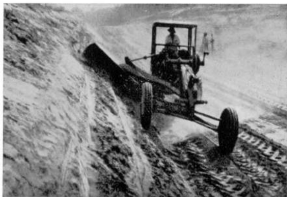
Jonction C. F. L.-K. D. L. / Section Kabalo-Kabongo. Niveleuse en action.
