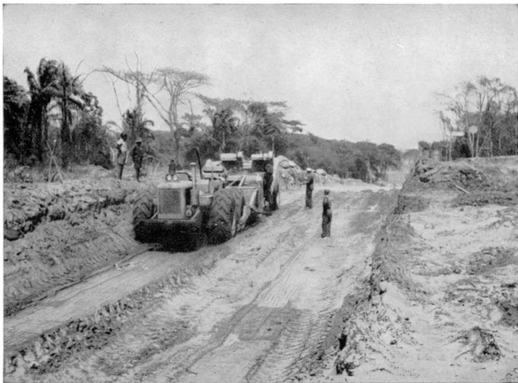
Jonction C. F. L.-K. D. L. / Section Kabalo-Kabongo. Terrassements par scraper.
