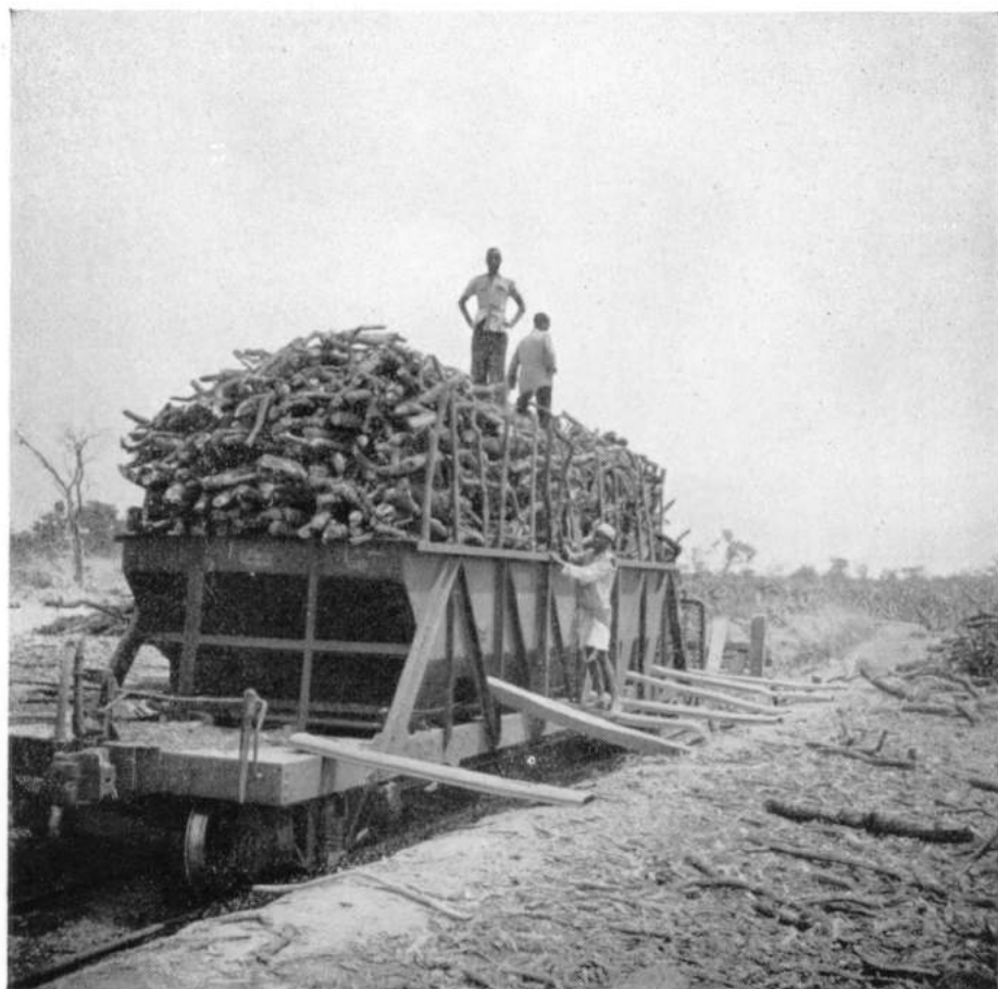
FIG. 9. — Wagon trémie chargé de bois de chauffage.
