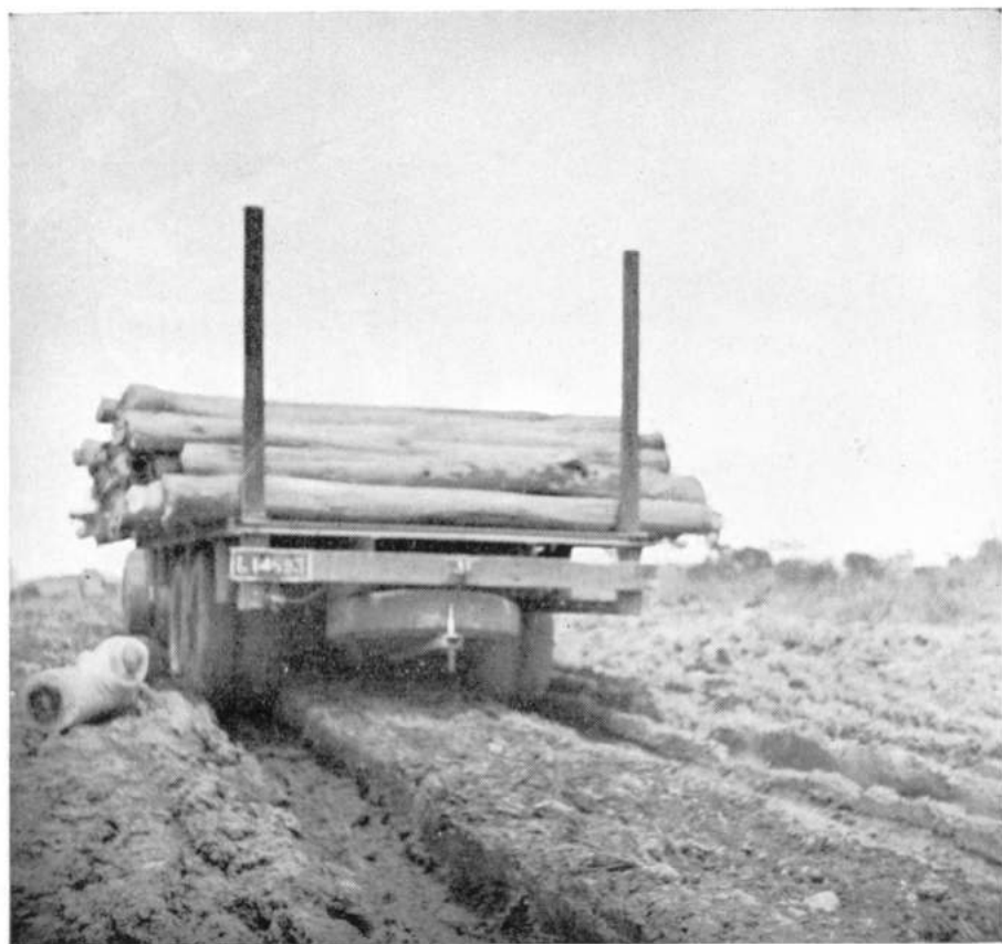
FIG. 14. — Piste principale d'évacuation en saison des pluies. Les 235 chevaux des deux moteurs suffisent à peine pour faire avancer le véhicule.
