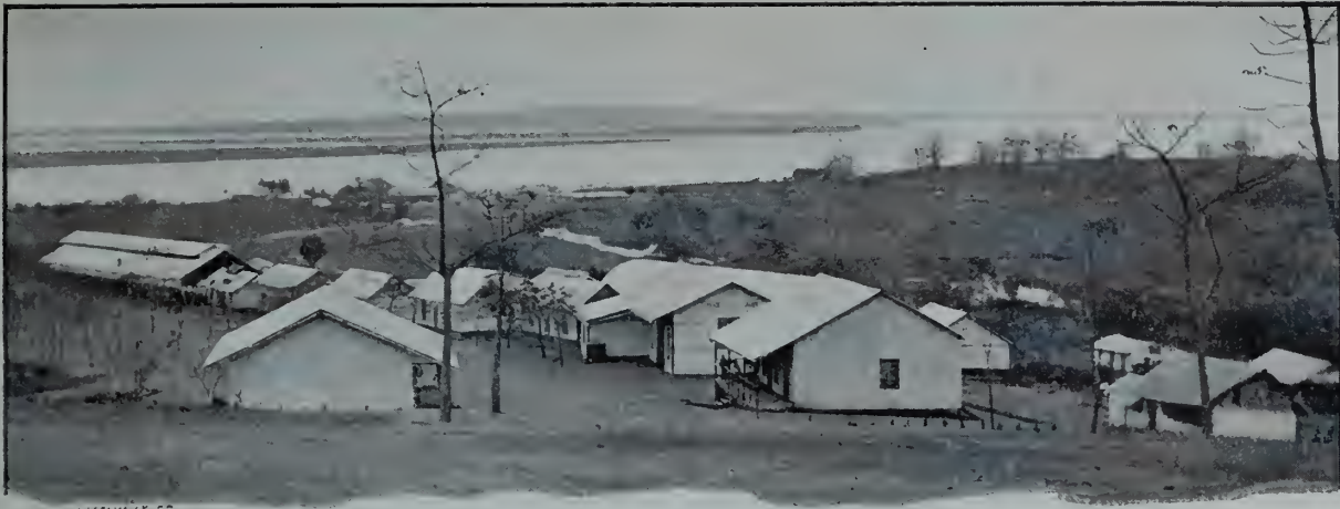
Les installations de la Force publique à Bcma. (D'après une phot de M. Shanu.)
