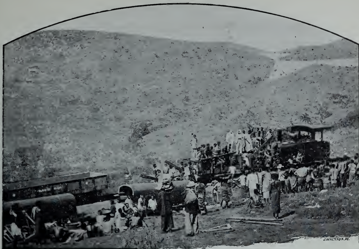
Déchargement d'un train de matériel à l'avancement des travaux. (D'après une phot. du Dr Étienne.)
