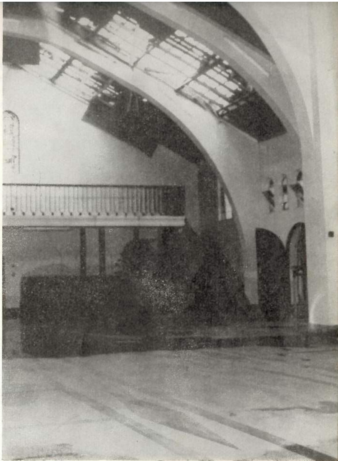
Eglise de la Lubumbashi. (Destruction par mitrailleage d'avion O.N.U.)
