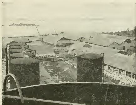
Installations Lever frères.
