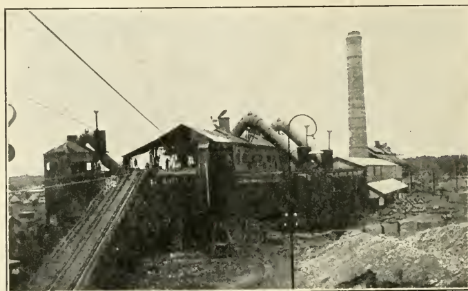
Un plan incliné amène le cuivre brut au moyen de wagons sur les plates formes des hauts fourneaux.
