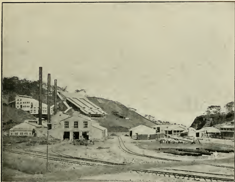
Ensemble de l'Usine de la Panda. (Photo Union Minière.)
