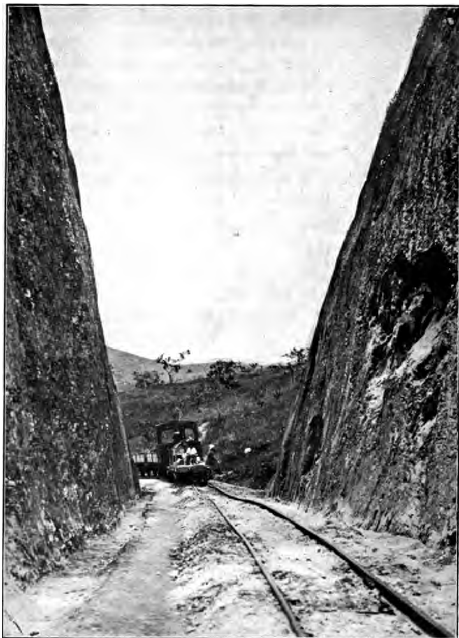
Tranchée au kilomètre 18. (Voie et train de travaux.)
