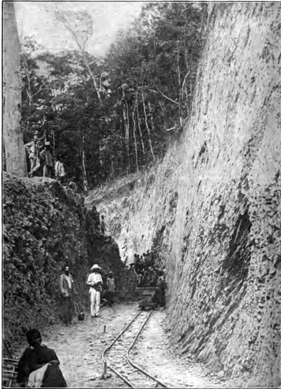
Tranchée au kilomètre 70.
