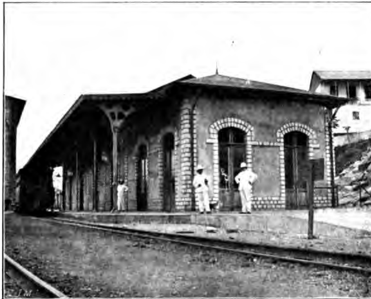
Bâtiment des recettes de Matadi.
