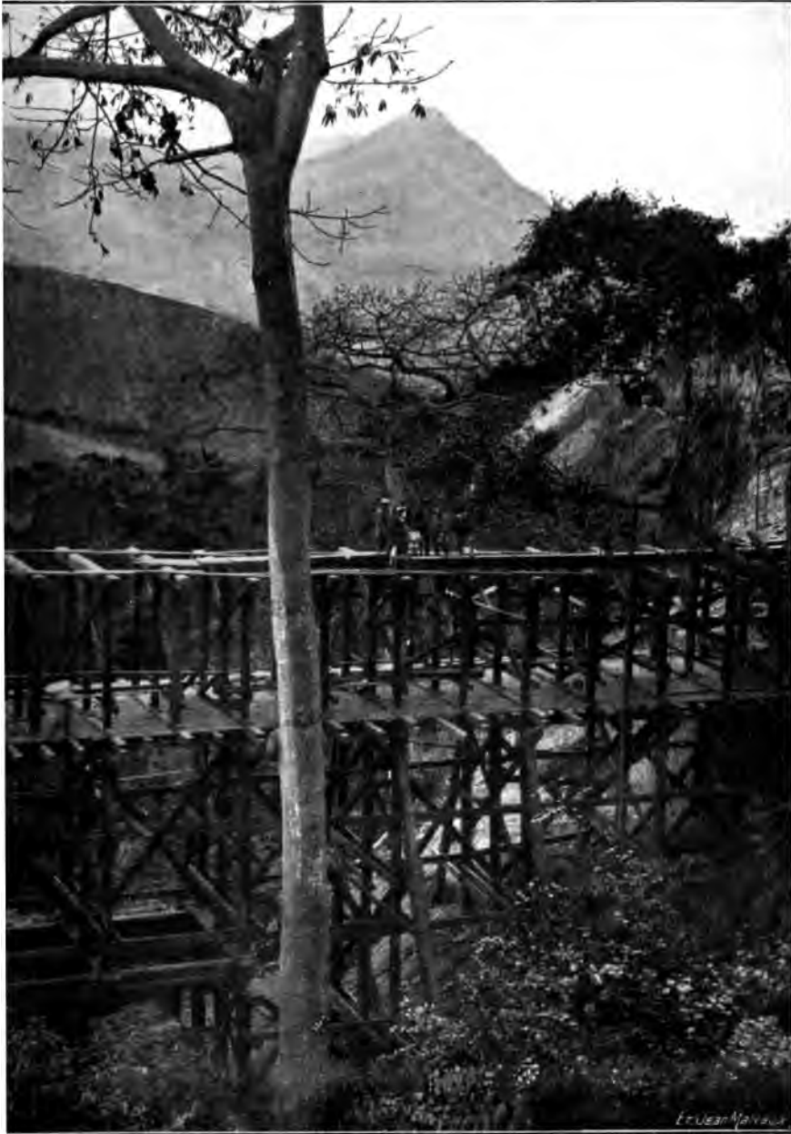
Pont de montage du tablier du pont du kilomètre 13.
