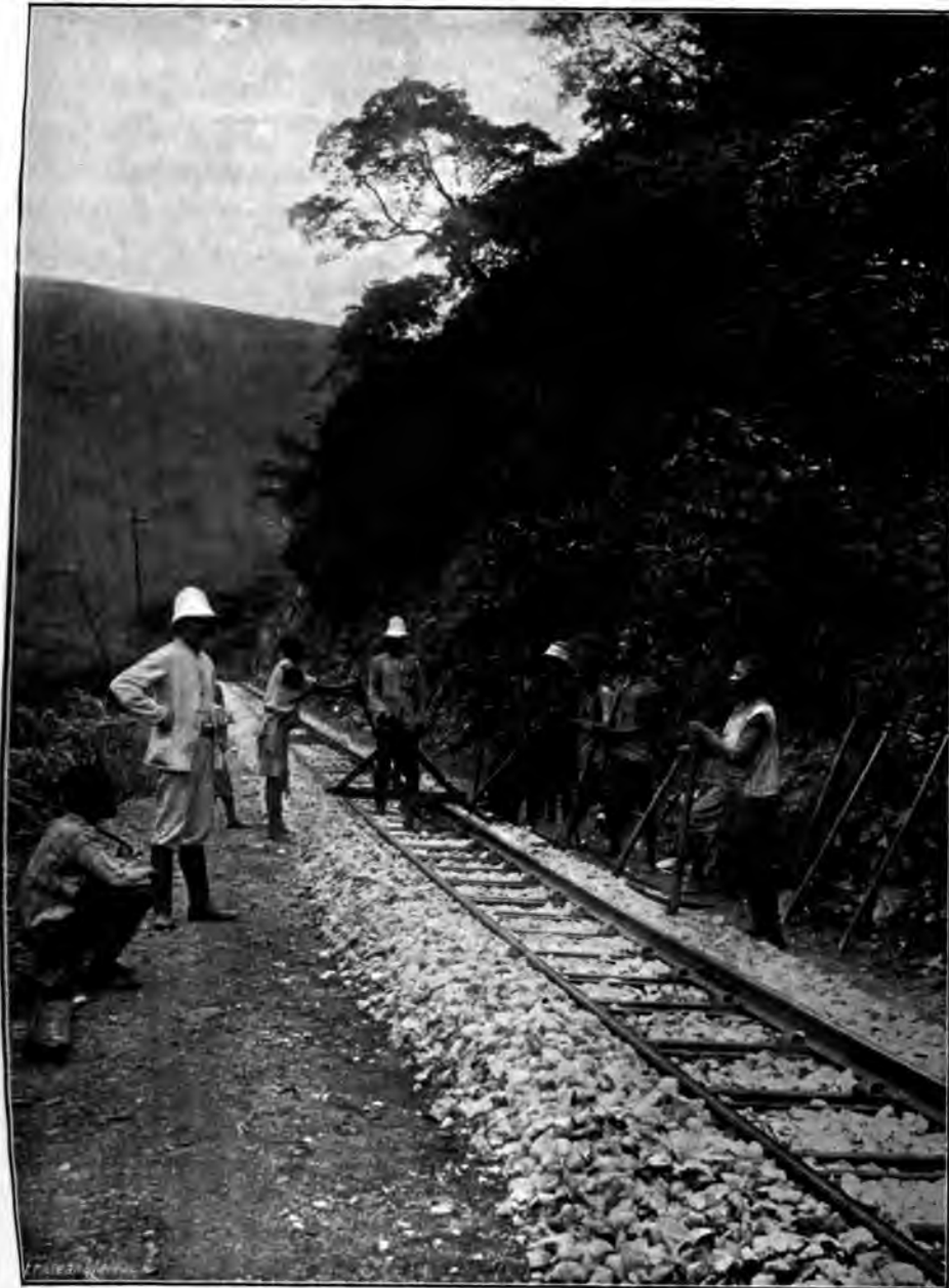
Entretien de la voie. (Traverses du type employé sur les premiers kilomètres.)
