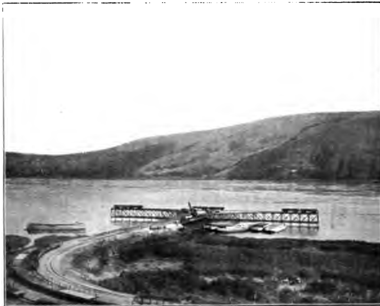
Matadi. Pier aval.
