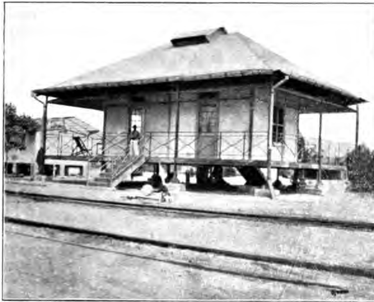
Bâtiment en acier et béton.
