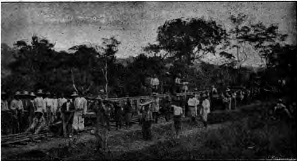
Au bout du rail. — La pose de la voie.
