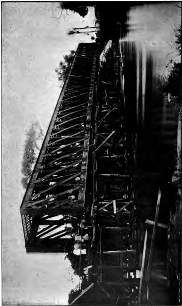
LE LANÇAGE DU PONT DE 100 MÈTRES SUR L'INKISSI
