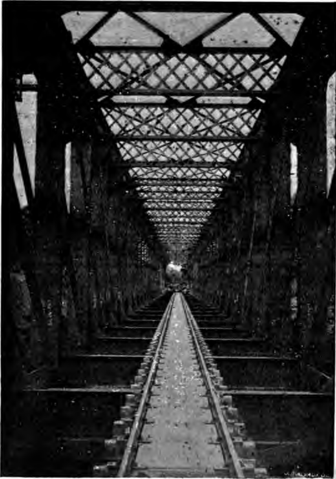
Le pont de 100 mètres sur l'Inkissi.
