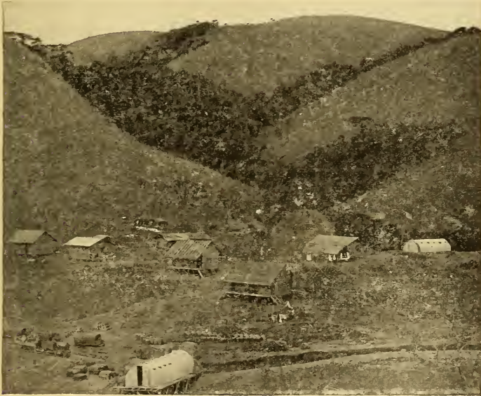
Fig. 39. — LA FORÊT EN GALERIE. — Campement de blancs au kilomètre 19 (construction du chemin de fer de Matadi à Léopoldville). — (D'après Goffin.)
