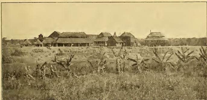
Fig. 85. — Vue générale d'une station militaire de l'État : Doungou en 1903. A l'avant-plan : jeunes bananiers. (Photogr. Lemaire.)
