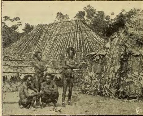
Fig. 65. — HUTTES RECTANGULAIRES construites et en construction.
