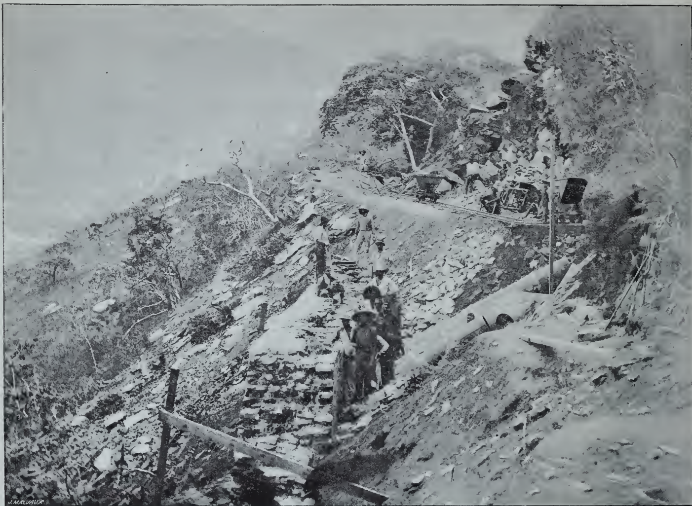
Construction du chemin de fer.
