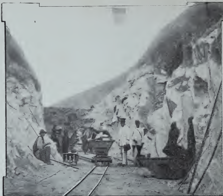
La tranchée du col de Palaballa.
