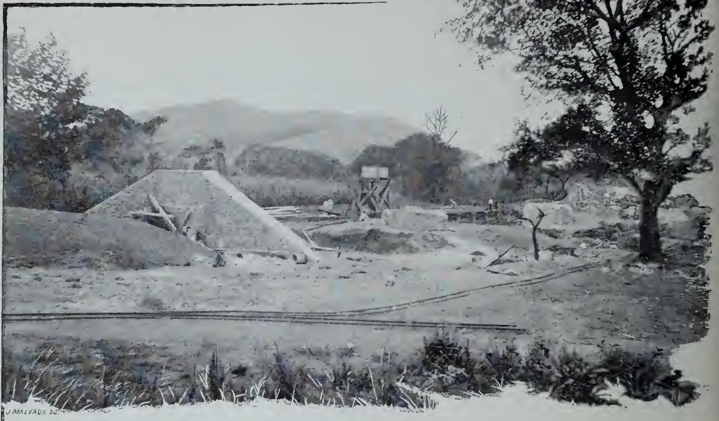
Construction du pont de la Kibueza (kilom. 33.250). (D'après un cliché de M. l'ingénieur Limmelyn.)
