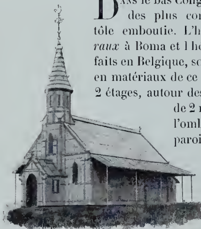
L'église en fer de Boma. (D'après un cliché de M. De Meuse.)
