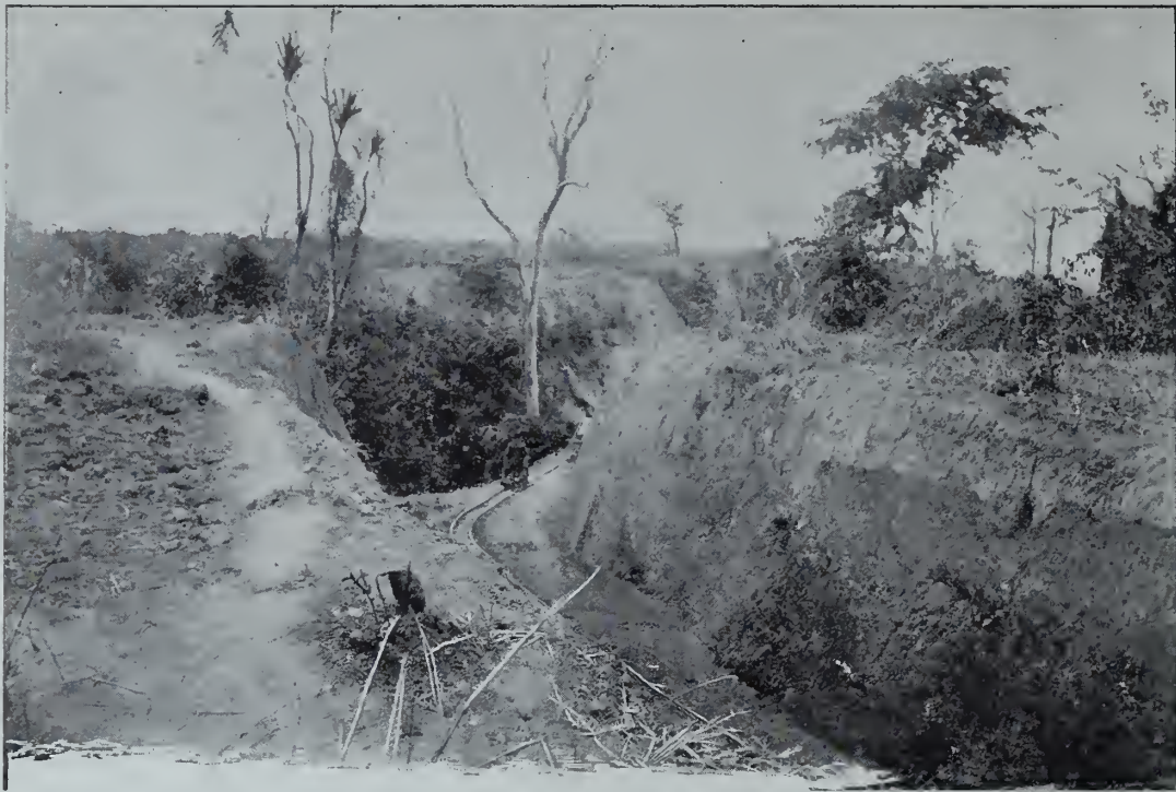
La tranchée de Kenge, au kilomètre 39. (D'après une photographie de M. l'ingénieur Limmelyn.)
