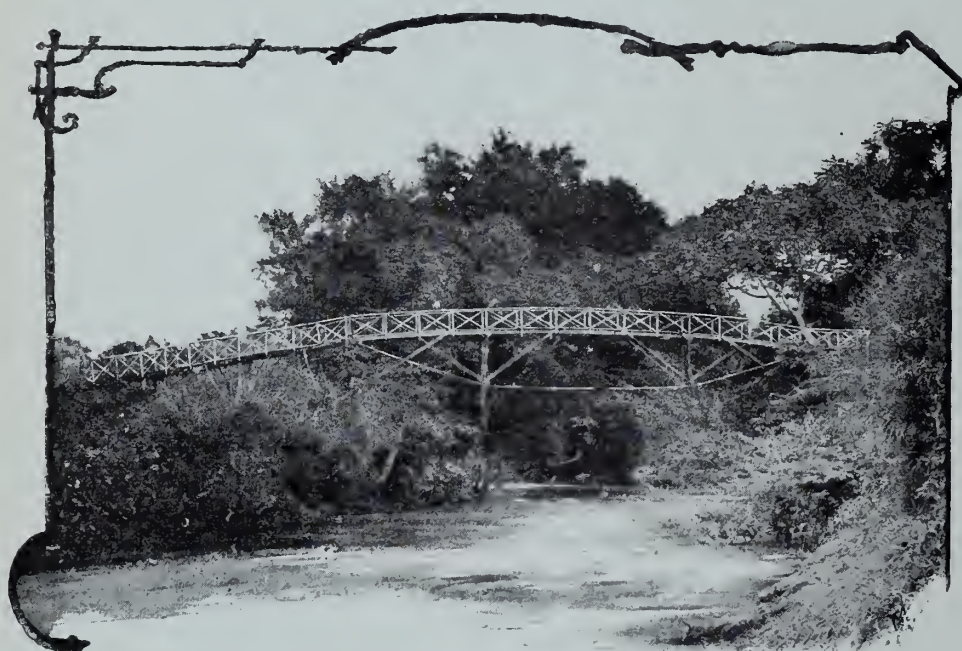
Pont suspendu sur la Lukunga (région des cataractes).
