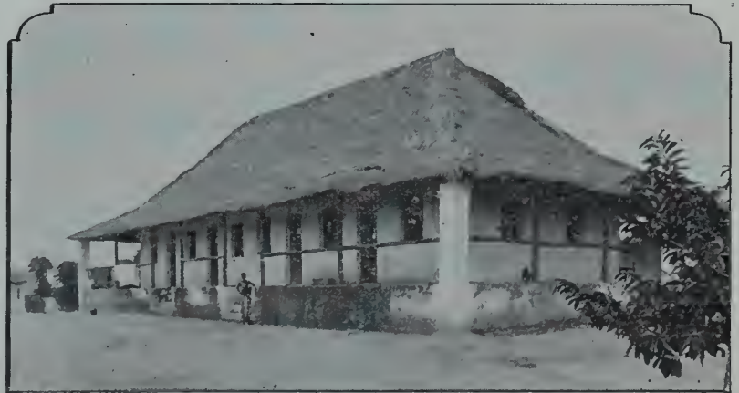
Maison d'habitation à Bazoko. (D'après une phot. de M. Michel.)
