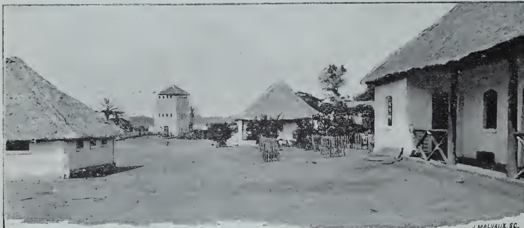
Cour intérieure de la station de Bazoko. (D'après une phot. de M. Michel.)
