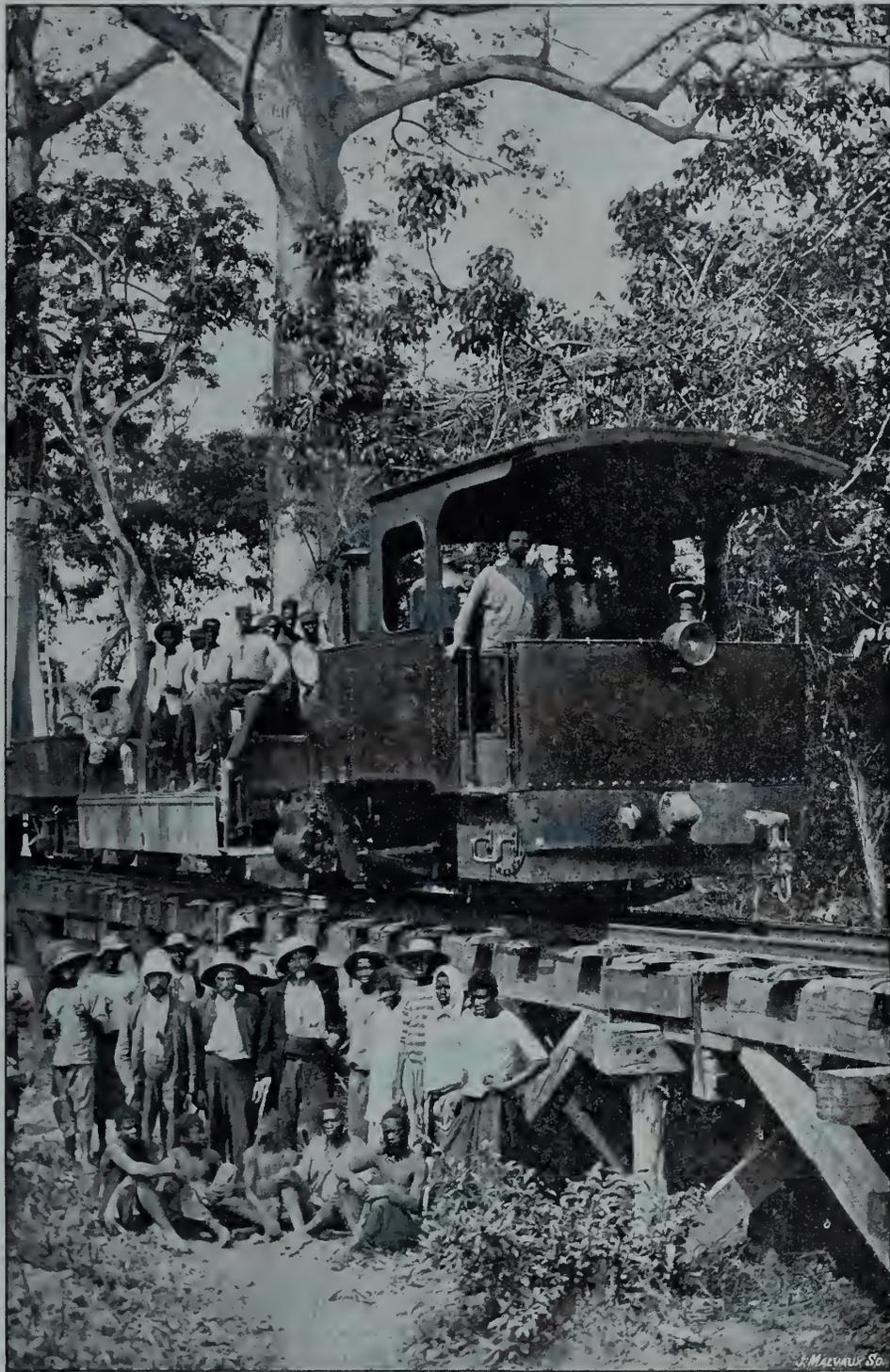
Fig. 3. — Passage d'un train de construction sur l'estacade de service du ravin de la Mi-Kengè, kil. 41,5.
