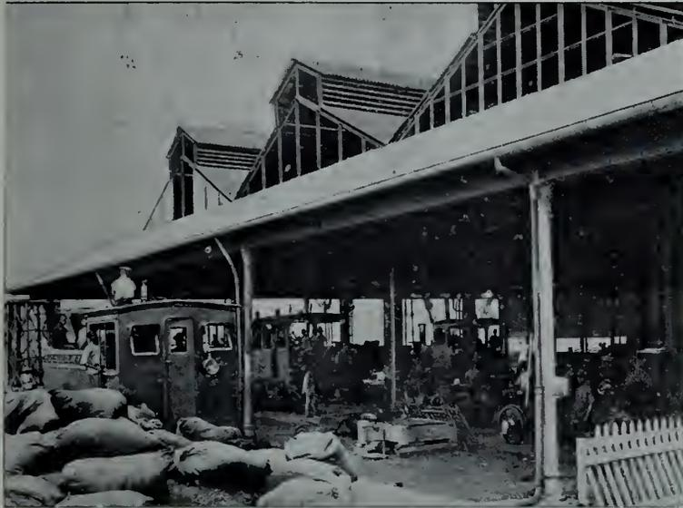
la Société anonyme « L'Industrie », de Louvain. Elle mesure 60 mètres de longueur sur 30 de largeur et renferme les forges, les tours à bandages et autres, toutes les machines-outils, etc. Sous la véranda, en communication avec le château d'eau, sont installées deux cabines de bain, avec appareils à douches pour les Européens et les noirs des ateliers. Elles rendent les plus grands services.
