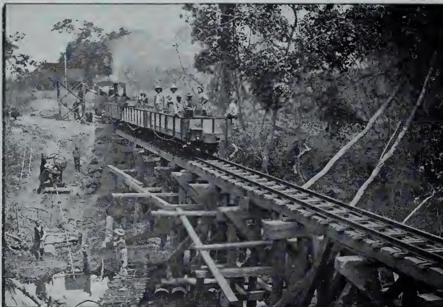
N° 2. — Passage d'un train de construction sur une estacade de service.
