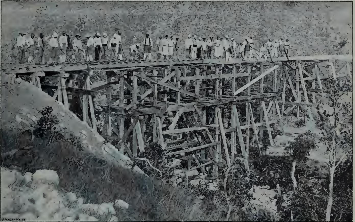
N° 1 — Pose de la voie sur le pont de service du ravin de Pondené, kil. 17.5.
