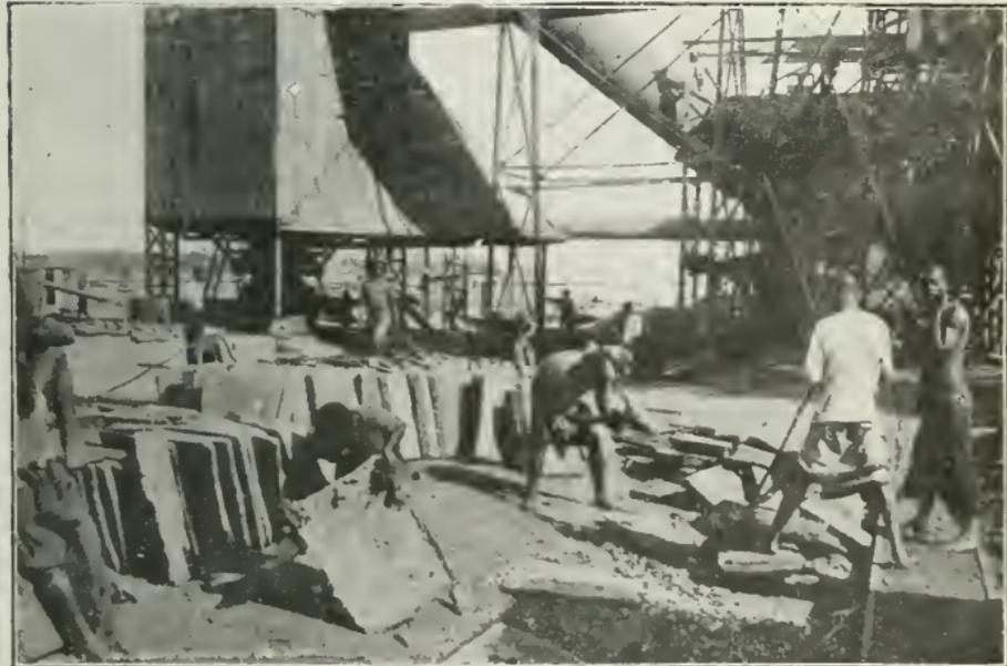
FIG. 17. — Mise en tas des lingots de cuivre.
