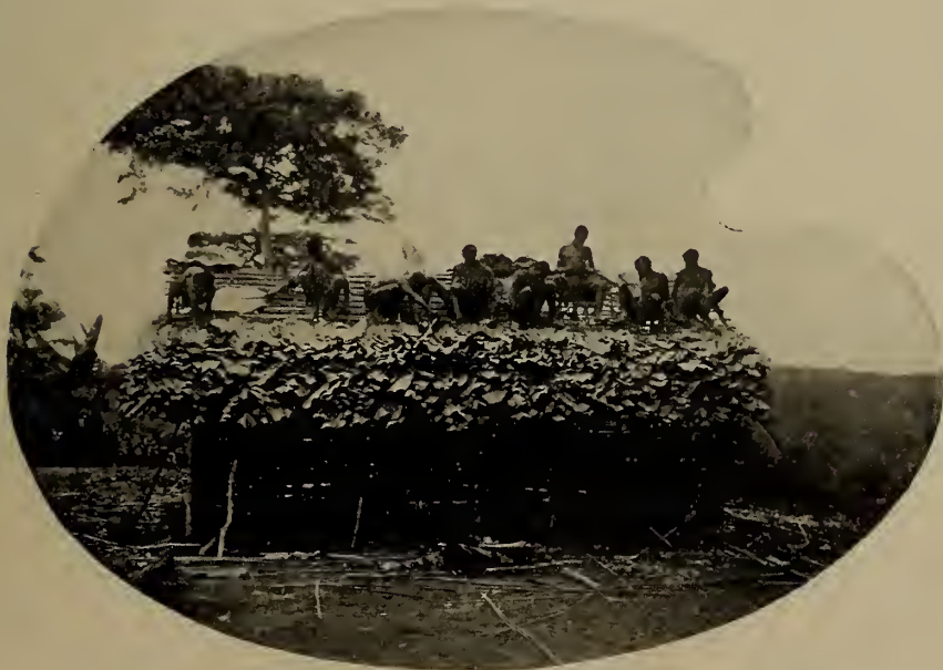
QUATRIÈME PHASE DE LA CONSTRUCTION D'UNE HABITATION
