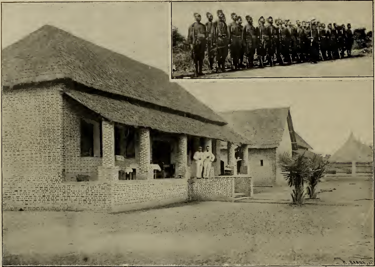
POSTE DE SURANGO (ZONE DU BOMOKANDI)
