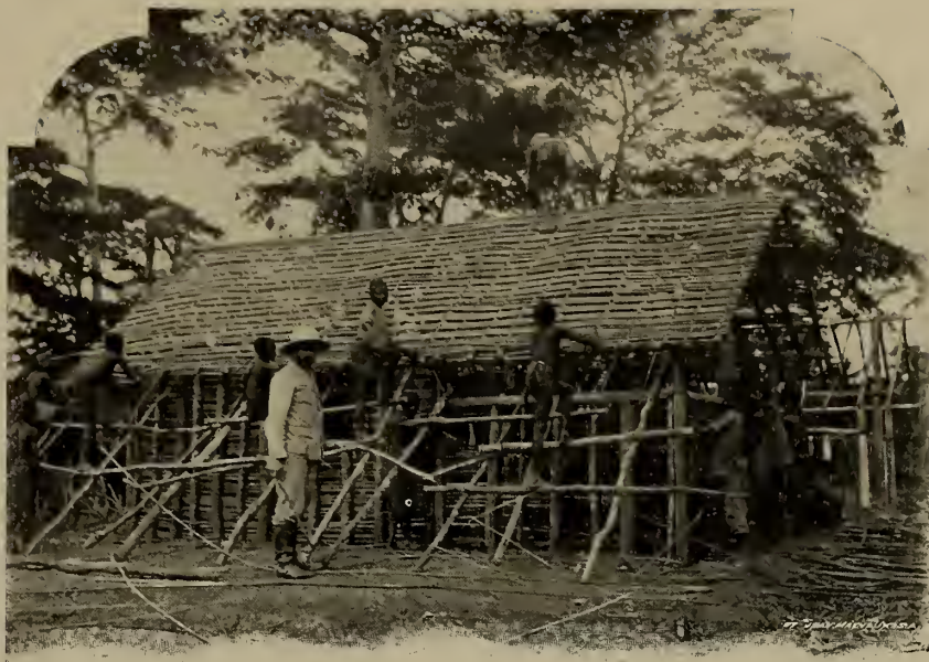
TROISIÈME PHASE DE LA CONSTRUCTION D'UNE HABITATION
