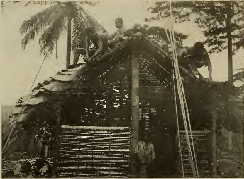
QUATRIÈME PHASE (VUE DE PROFIL) DE LA CONSTRUCTION D'UNE HABITATION
