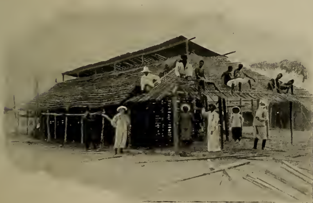
CONSTRUCTION D'UNE TOITURE AVEC DES RACHIS DE PALMIER-RAPHIA
