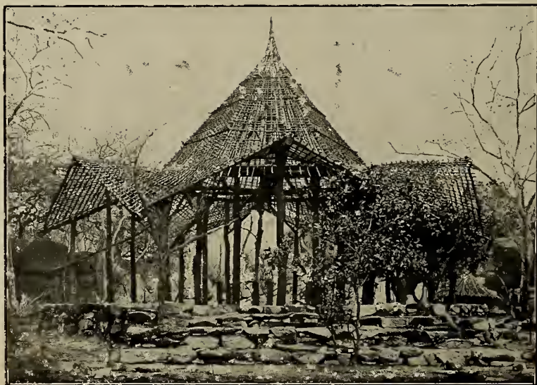
SALLE A MANGER EN CONSTRUCTION
