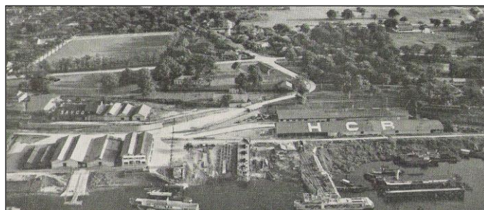
Port de Léopoldville. Infrastructures importantes de stockage.
