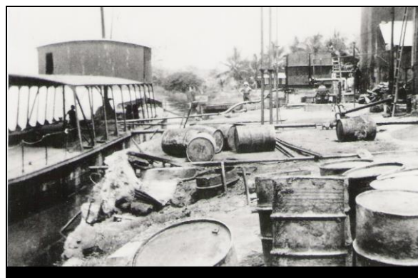
Transport de l'huile en vrac dans des barges citernes. Installation de pompage de l'huilerie de Dima, Compagnie du Kasai
