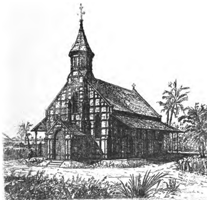
Nouvelle Eglise de Boma. (Cette église construite toute en fer dans les ateliers d'Aiseau (Belgique), mesure 25 m. de long sur 12 de large. Les doubles parois permettent la circulation de l'air, qui rafraîchit l'intérieur.)
